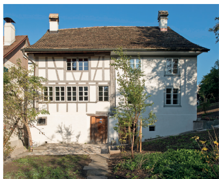
Sanierung Doppelwohnhaus, Zürich
