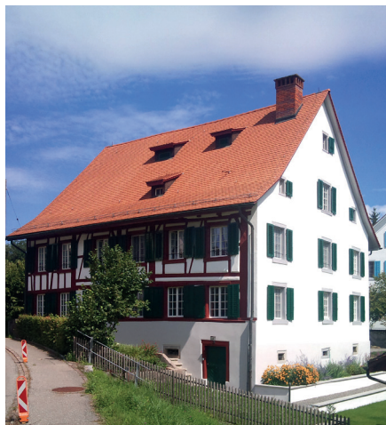
Sanierung Pfarrhaus, Maschwanden
