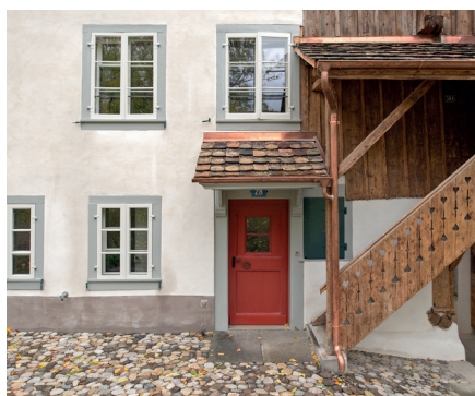
Eingangsbereich saniertes Doppelwohnhaus
