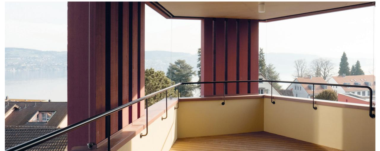
Das Mehrfamilienhaus «4Sisters» in Wädenswil ist in Massivbauweise erstellt. Die Fassade war zunächst aus Beton geplant, musste aber aus Gründen der Kostenoptimierung einer Holzfassade weichen.
