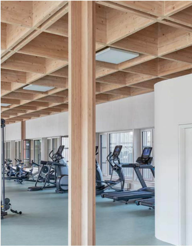
4 Ein quadratisches Stützenraster, das ein Gitter aus Brettschichtholz trägt, bildet die einfache Grundkonstruktion des Baus.
