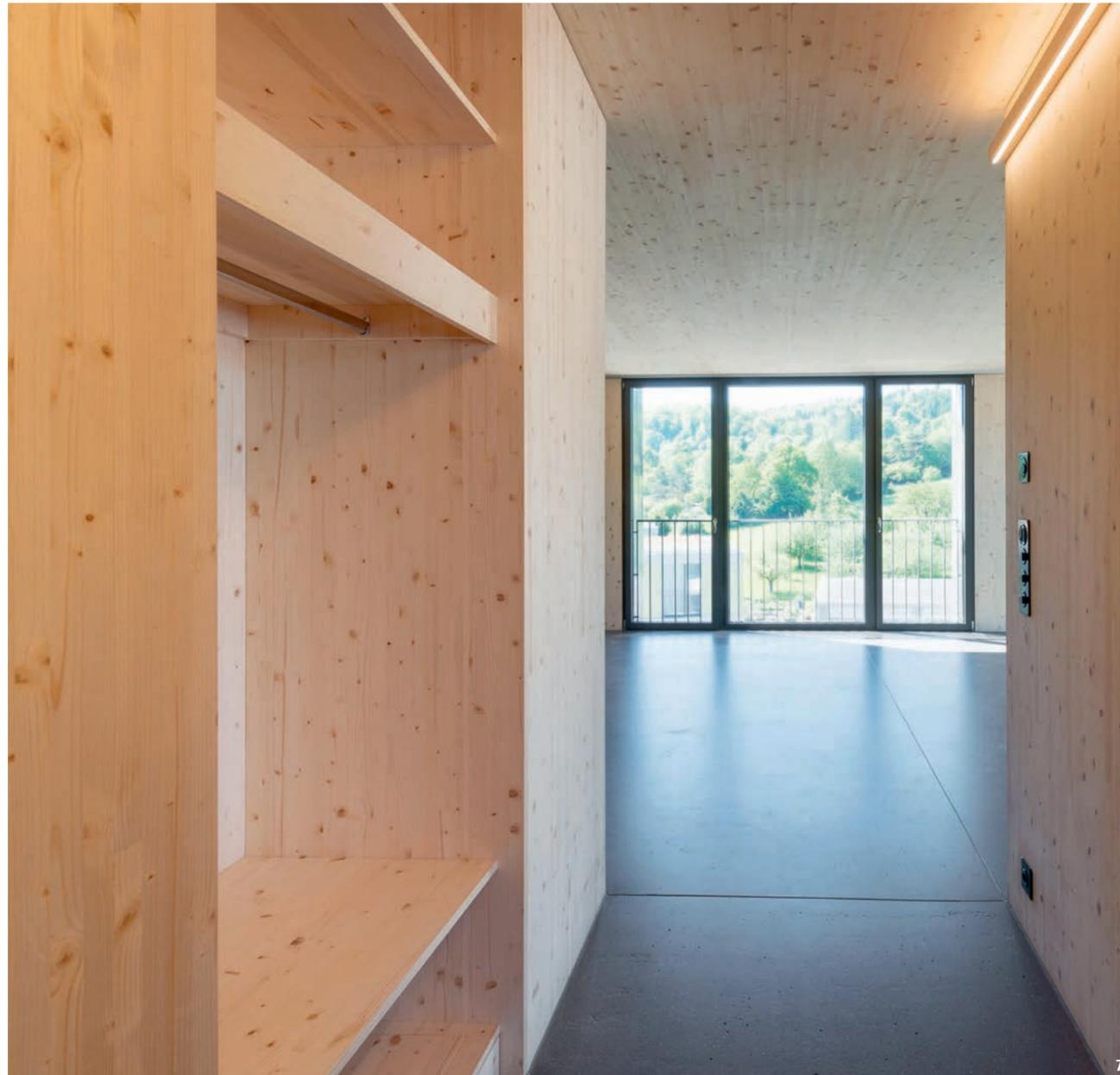
7 Das aufgestockte Attikageschoss besteht aus einer hochgedämmten, vorgefertigten Holzkonstruktion.
