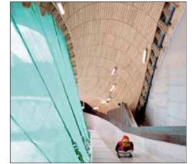
Die Überdachung der Rennrodelbahn ist weitestgehend stützenfrei ausgeführt. Auf der Innenseite erhält die neue Dachschaale eine Holzleistschalung. Fotos: Trabert+Partner (li.), R. Knoll/Zweckverband Thüringer Wintersportzentrum (re.)
