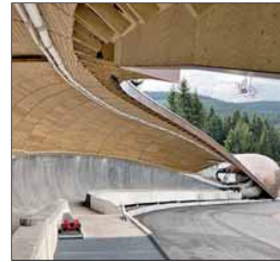
Die Überdachung der Rennrodelbahn ist weitestgehend stützenfrei ausgeführt. Auf der Innenseite erhält die neue Dachschaale eine Holzleistschalung. Fotos: Trabert+Partner (li.), R. Knoll/Zweckverband Thüringer Wintersportzentrum (re.)
