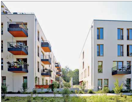
Mit dem „Quartier WIR“ entstanden in Berlin 160 genossenschaftliche Mietwohnungen, 38 Eigentumswohnungen sowie neun Gewerbeeinheiten und Gemeinschaftsräume mit insgesamt 12 400 m 2 Nutzfläche. Foto: L. Glowatzki
