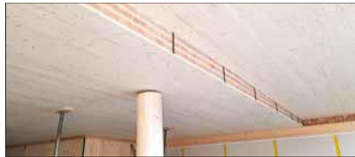
Dicht- und Segmentbänder am Plattenstoß
