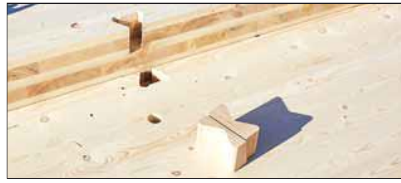
Für die Montage werden die schwalbenschwanzförmigen „X-fix“-Holz-Holz-Verbindere eingesetzt.
