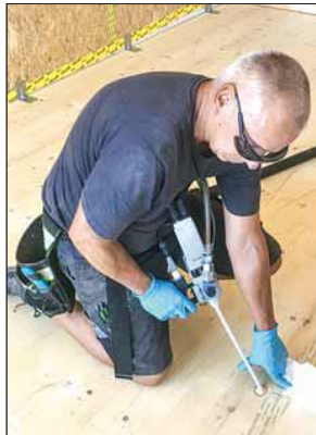
Anwendungstechniker beim Einbringen des Gießharzes an den Plattenstößen
