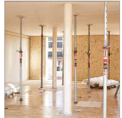
Absprießen der Deckenfläche während des Aushärtens des Gießharzes. TS3 ermöglicht ein Stützenraster bis 8 x 8 m.
