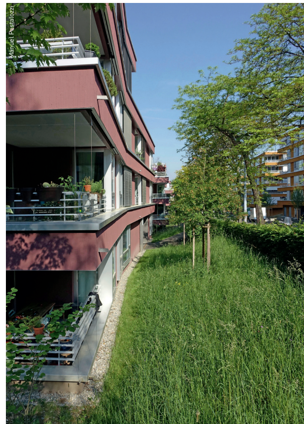
Im unteren Teil der Anlage wird der Verlauf des Terrains maximal ausgenutzt.
