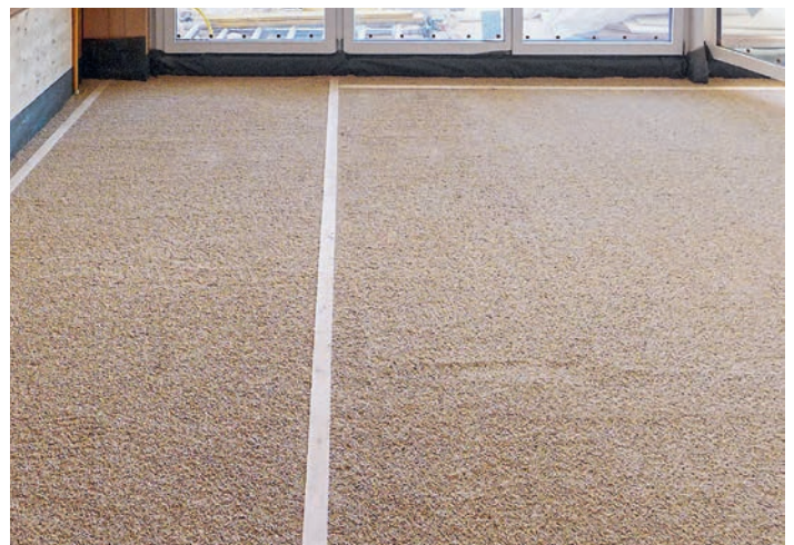
Das Einbringen der schweren ungebundenen Kalksplittschüttung hat sich für einen wirksamen Schallschutz bewährt.
