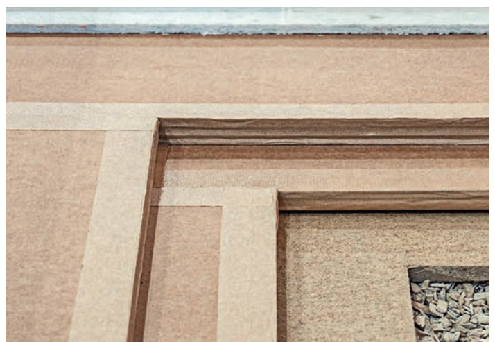
Eine Spezialität der Holz und Funktion AG sind mit Sand gefüllte biegeeweiche Platten gegen den Schall.
