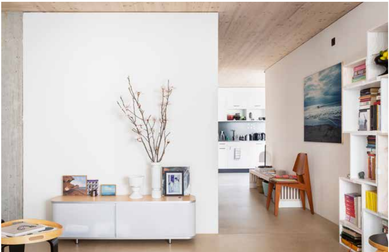
Eine Wohnung im zweiten Obergeschoss: Die feine Fuge zur Decke deutet darauf hin, dass sich die nicht tragenden Elemente der Wände einfach versetzen lassen.
