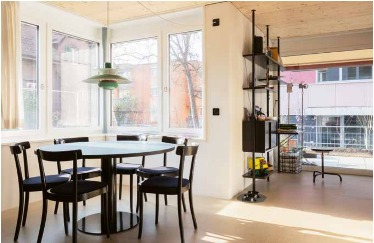
Eine Wohnung im Erdgeschoss mit durchlaufenden Decken ohne Unterzüge. Eine Stütze in der Fensterecke dient der Statik der Konstruktion.
