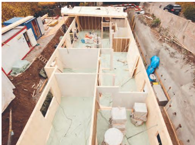
Selbst der Keller ist aus Holz gefertigt: Auf einer 16 Zentimeter dicken Dämmplatte liegen Brettsperrholzplatten auf; eine EPDM-Folie ummantelt das Holz für den Feuchteschutz.
