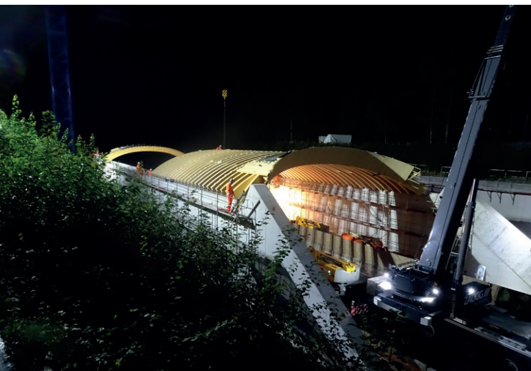
12 13 Montage der einzelnen Binder zwischen den Portalmodulen © Timbatec Holzbauingenieure Schweiz AG
