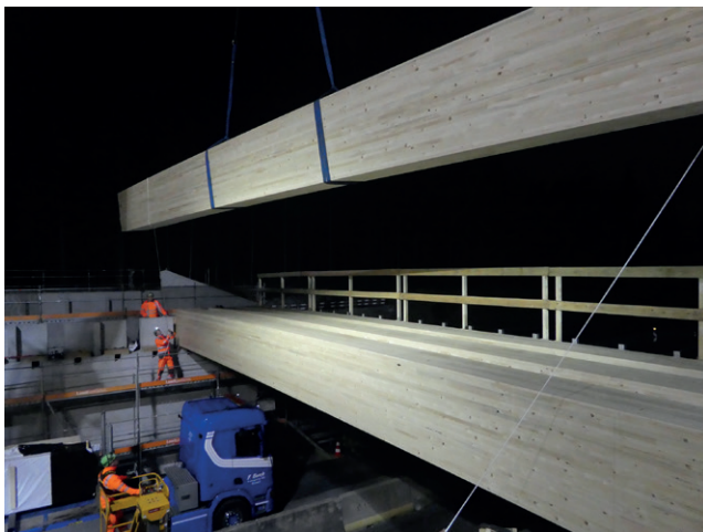
23 24 Trägermontage während nächtlicher Fahrbahnspernung © Timbatec Holzbauingenieure Schweiz AG
