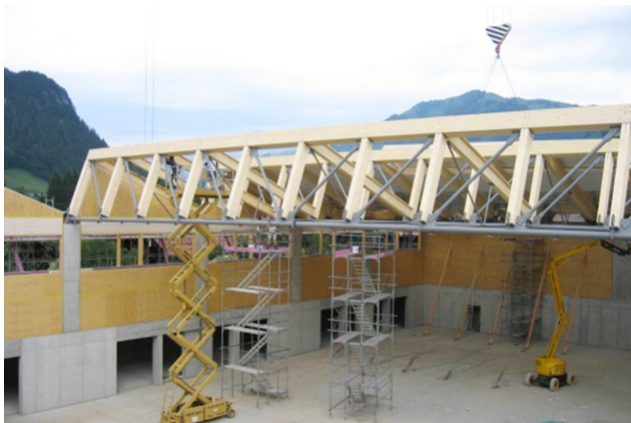
Montage de poutres en treillis
