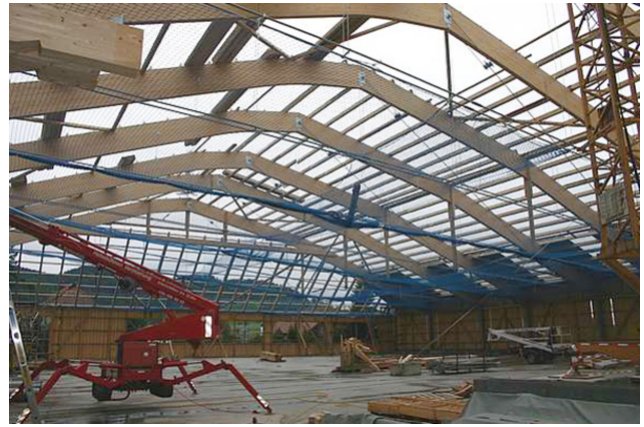
Mise en place du liant
