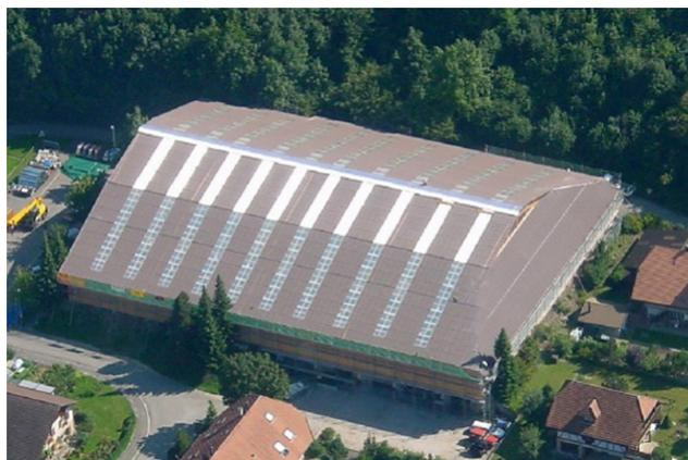
Un toit devait être construit au-dessus de l'abri de protection civile existant pour la patinoire jusqu'alors ouverte. Les lignes de construction ne laissaient guère de marge de manœuvre quant à la forme du toit. Les limites devaient être respectées non seulement en plan, mais aussi en coupe.
