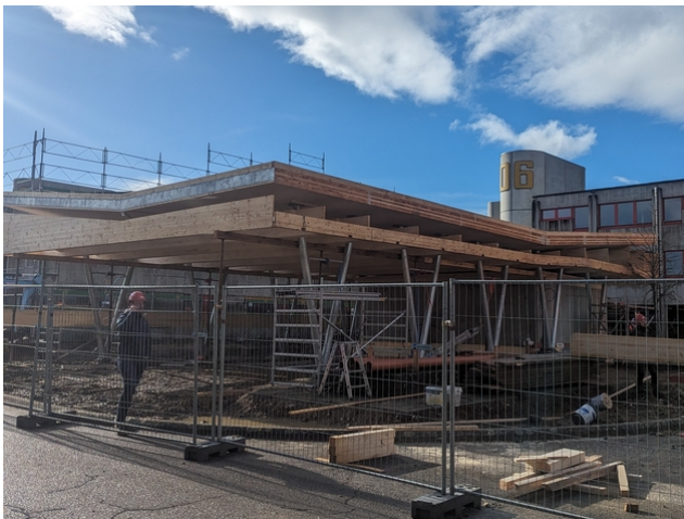
Impression du chantier
