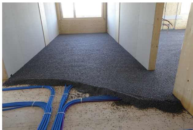
Remblai sec à liant élastique
