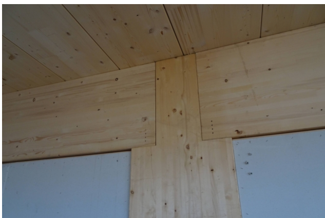
Appui des poutres sur les poteaux
