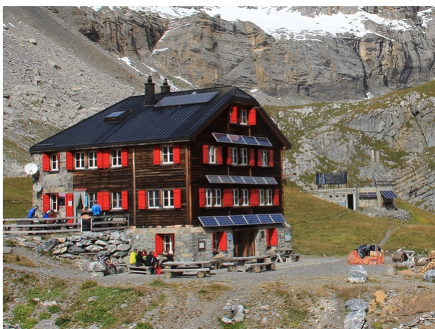
La Lämmerenhütte avant l'extension
