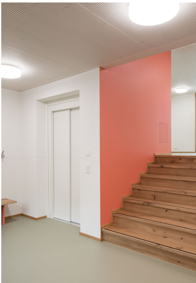
Escaliers avec panneaux en chêne massif
