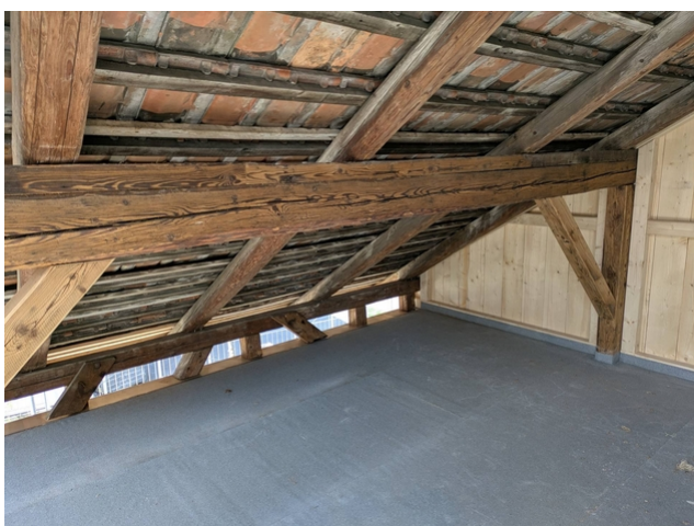
Une protection constructive du bois aide à protéger la charpente contre la pénétration de la humidité.
