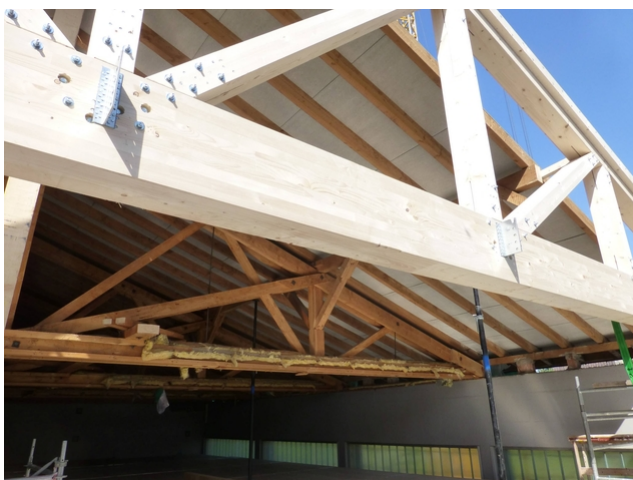
Ancienne et nouvelle ferme en treillis
