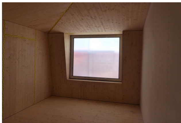
Vue intérieure pendant la phase de construction
