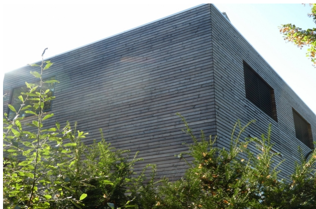
Vue de la façade
