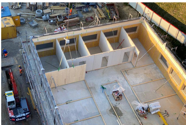
Montage des parois intérieures
