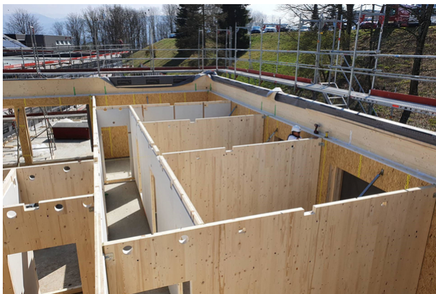
Murs intérieurs en bois lamellé-croisé
