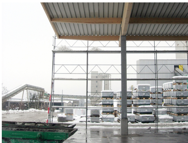
Poteau en acier et poutre en bois
