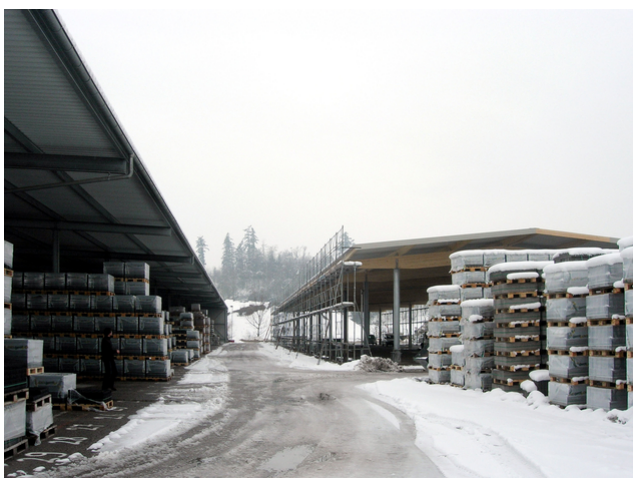
Ancien et nouveau toit
