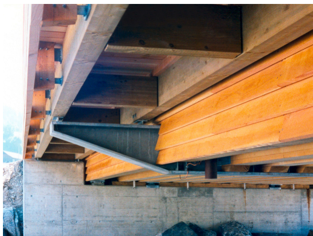
Traverse en acier intégrée
