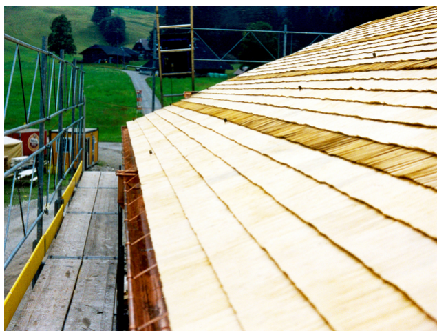
Travaux de bardeaux
