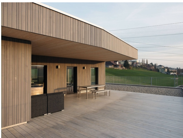
Accueillant : le dernier étage et le toit-terrasse du nouveau bâtiment
