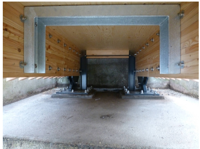
Le nouveau pont a été coincé dans la niche de pilier existante
