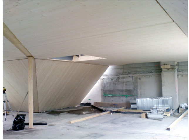
Vue intérieure de la gorge
