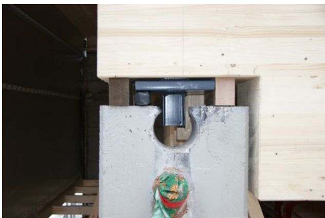
Soutien avant la coulée
