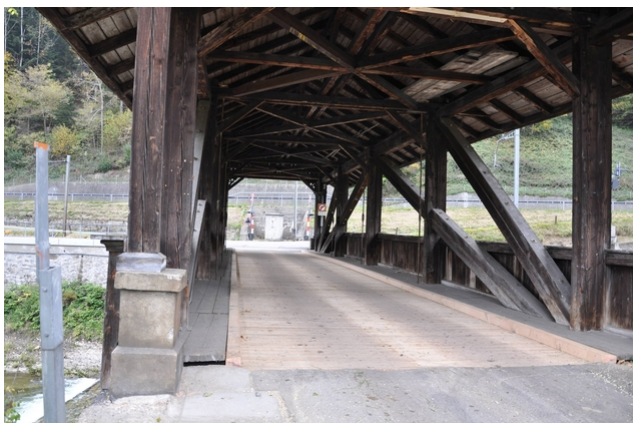
Nouvelle chaussée en planches de chêne aérées
