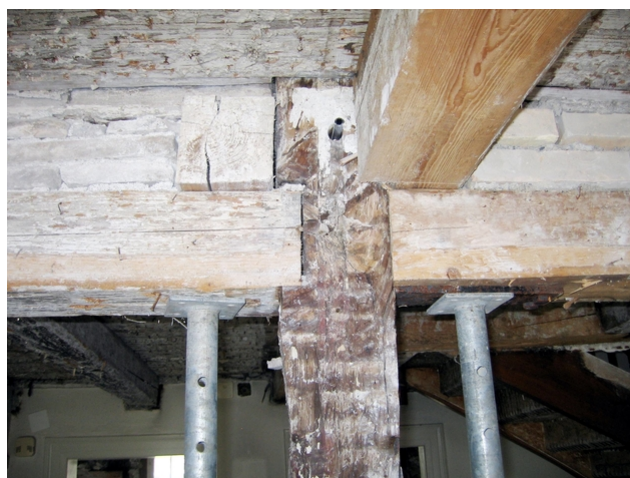
Soutien pour les poutres du rez-de-chaussée avant la rénovation
