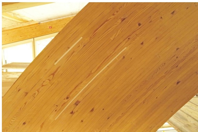
Vue détaillée d'un joint de colle rénové
