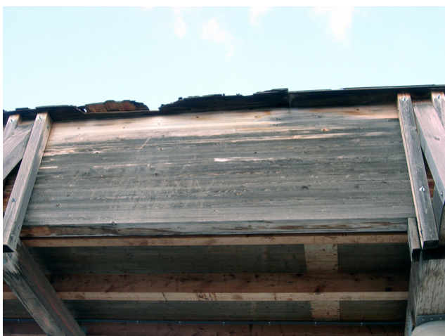
Passerelle avant la rénovation 2
