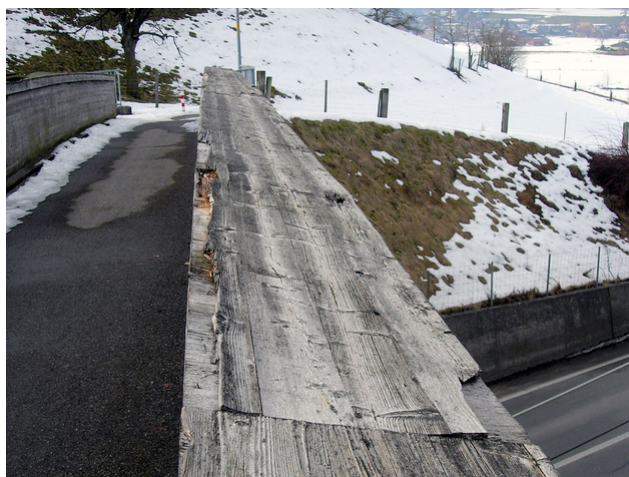
Passerelle avant la rénovation 1
