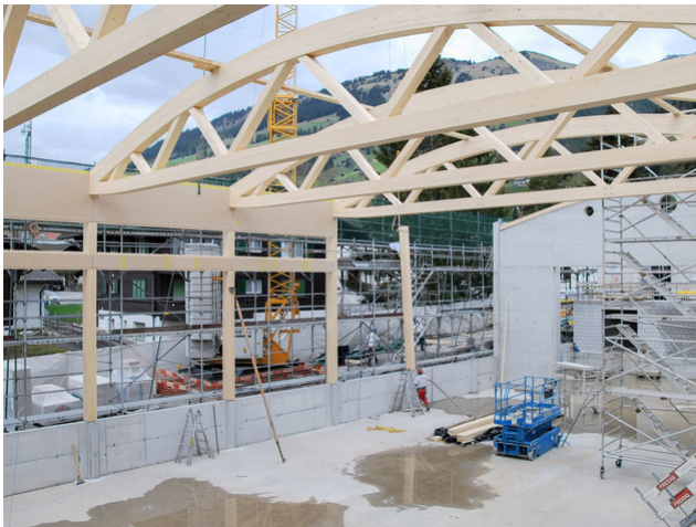
Plus grande hauteur de la structure porteuse grâce à l'aileron inférieur légèrement courbé vers le haut des poutres en treillis
