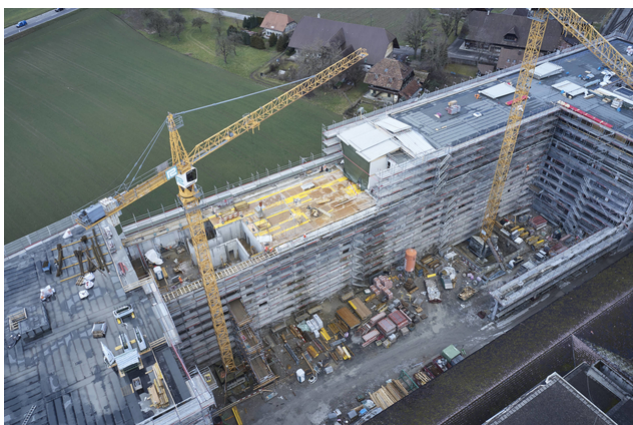
Vue aérienne pendant le redressement
