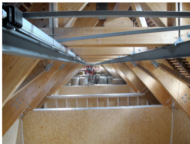
Voie de grue
