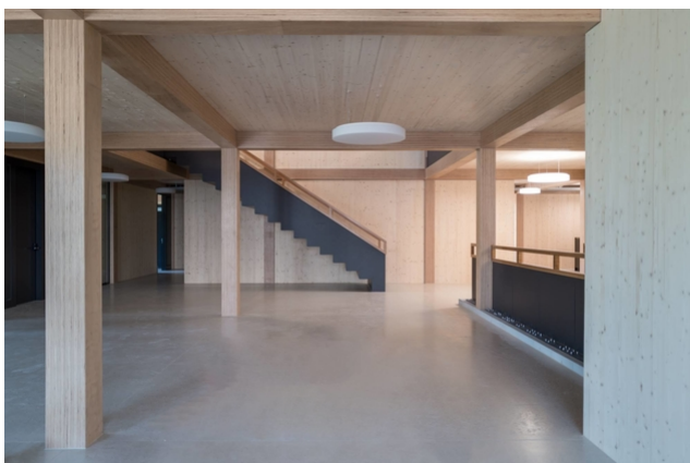
Vue intérieure avec supports en hêtre
