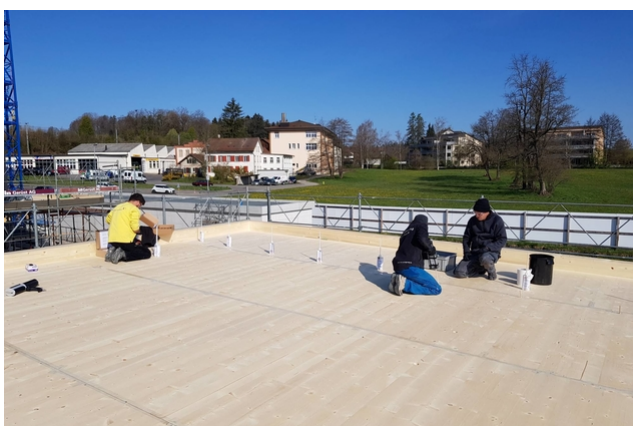
TS3 lors du scellement TS3 de l'avant-toit
