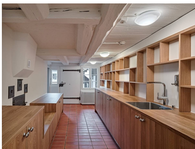
Vue de l'espace buffet dans l'ancien bâtiment (photos Roger Frei)
