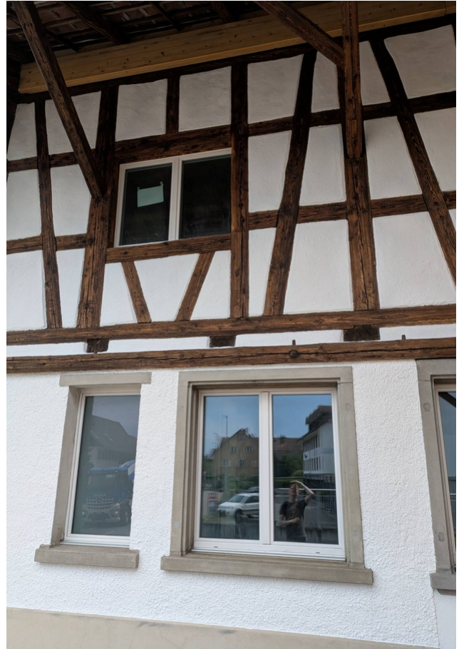
Die strassenseitige Fassade ist energetisch wie schallschutztechnisch ertüchtigt.
