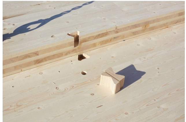
Das Gebäude während der Entstehung
