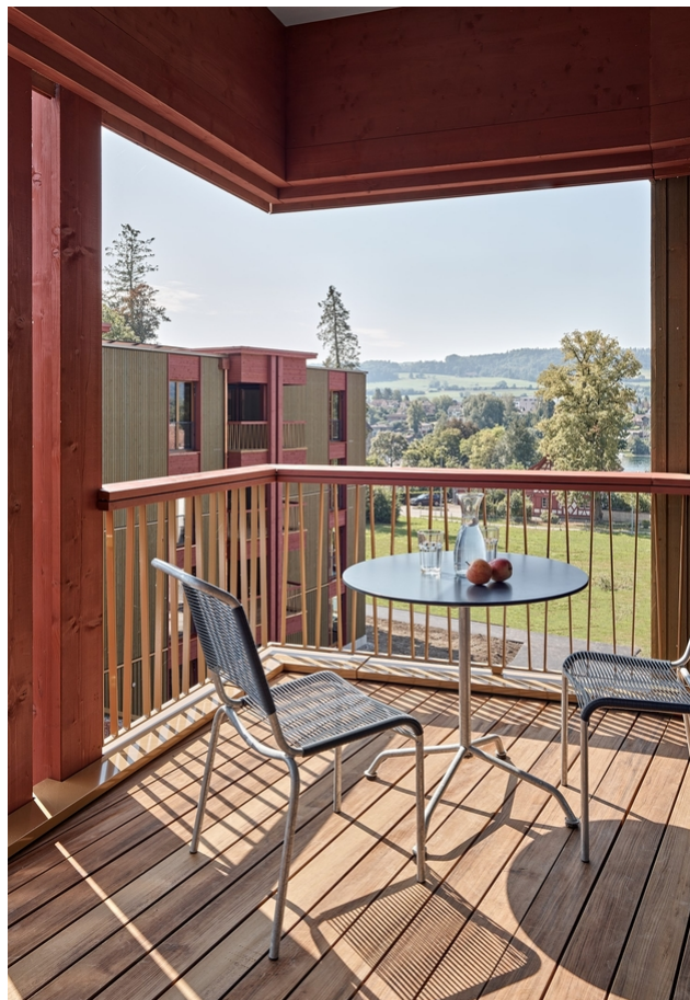
gedeckte Loggias im Aussenbereich
