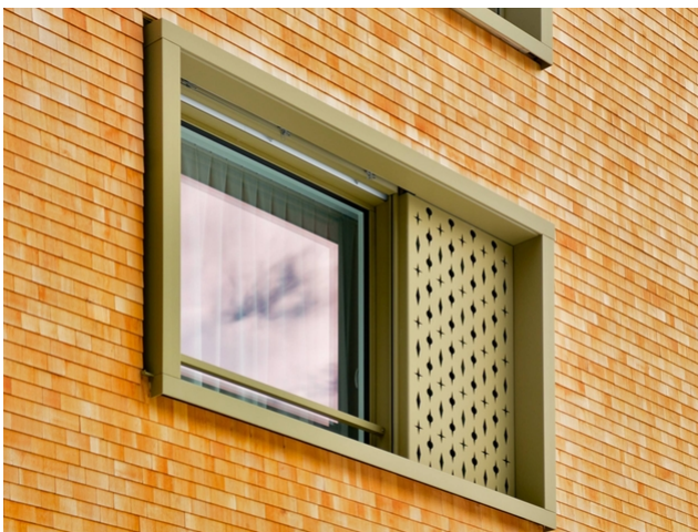
Im Detail: Teil der Lärchenholzfassade
