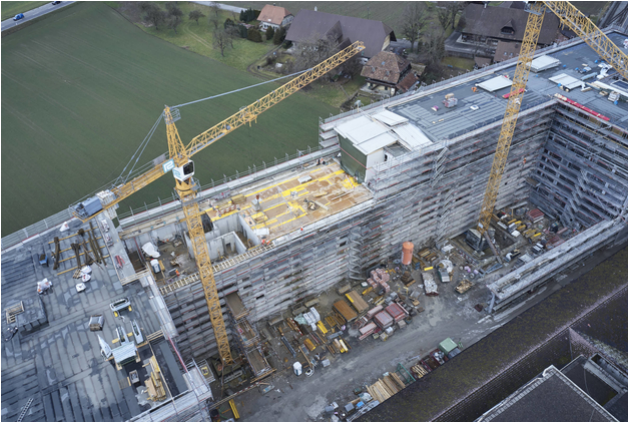
Luftaufnahme während dem Aufrichten
