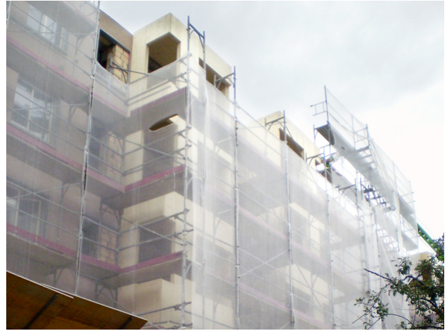
Aufstockung Erker Rohbau 2
