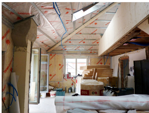
Wohnfläche bei der Renovierung
