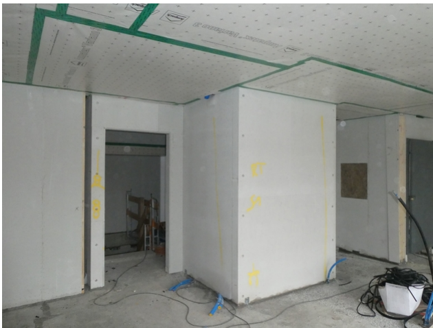
Gekapseltes Treppenhaus in der Bauphase
