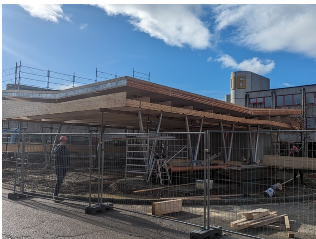
Verlegen der Platten, die auf die Zwischenkonstruktion geklebt werden.
