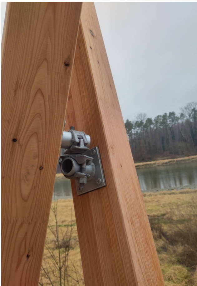
Verbindung der Gitterstäbe
