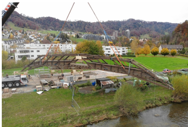
Montagearbeiten an der Brücke
